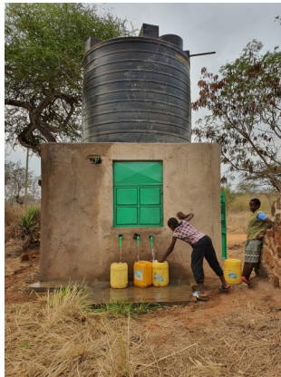
Château d'eau au Kenya
