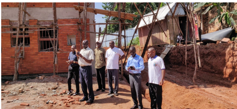
Visite du chantier avec l'équipe provinciale
