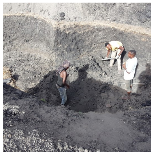
Le creusement des trous pour les deux chambres
